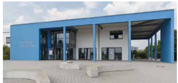
Technologie Campus Cham Badstraße 21 · 93413 Cham
